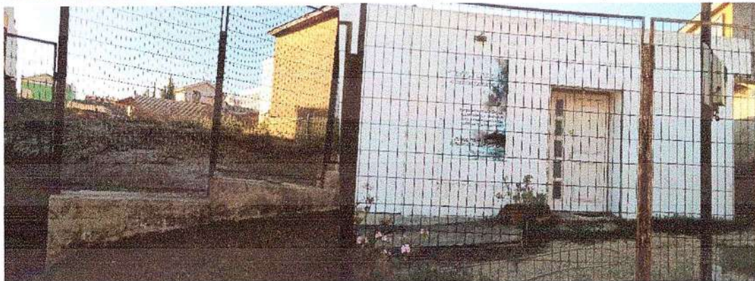
Regularización de terreno del Templo Evangélico
