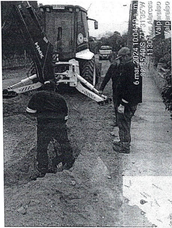
Foto 1: Excavación Calicata búsqueda de sumidero
