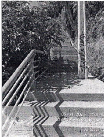
Inspección escalera el Prado
