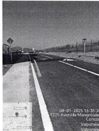
Inspección resalto reductor camino concón-reñaca oriente
