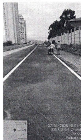
Inspección señalización camino concón-reñaca oriente
