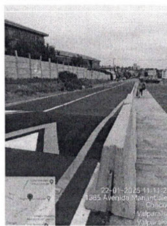
Inspección señalización camino concón-reñaca oriente
