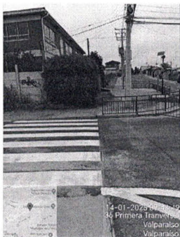
Inspección señalización camino concón-reñaca oriente
