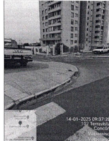
Inspección repintado paso peatonal y soleras calle concón-reñaca oriente
