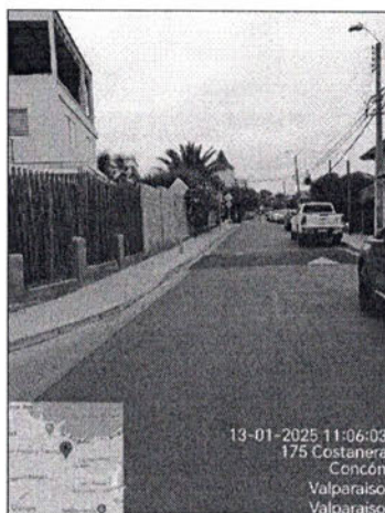
Inspección resalto reductor Calle Costanera
