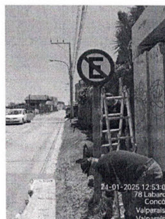
Colocación señalización "No estacionar" calle LaBarca
