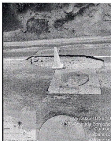
Inspección socavaciones en Avda Borgoño.
