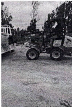
Apoyo Inspección recepción de materiales
