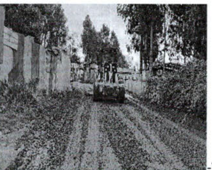
-Visita en terreno por construcciones irregulares, en el sector La Isla.
