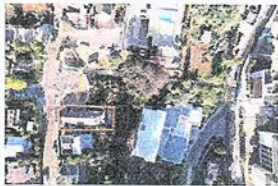
Figura 1: Situación de terreno en El Prado N°95 esquina Higuerillas
