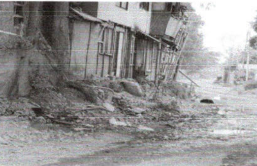
-Visita en terreno sector La Isla, por derrame de aguas grises en el camino.
