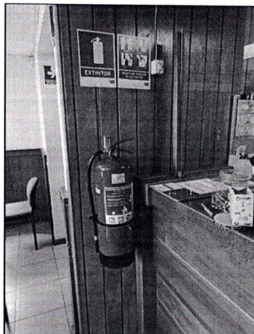
Instalación Extintores en Oficina Municipales según solicitud Prevención de Riesgos.
