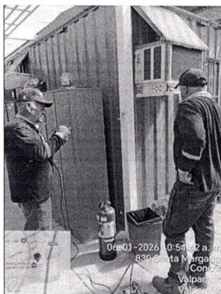
Instalación Extintores en pasillos oficinas Dimao.
