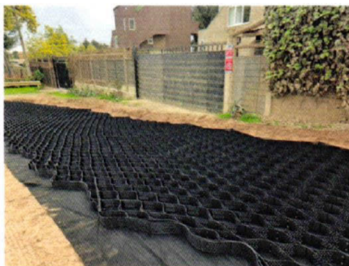
Instalación de geoceldas en Puente Las Violetas
