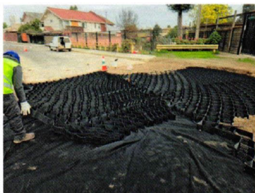
Instalación de geoceldas en Puente Las Violetas
