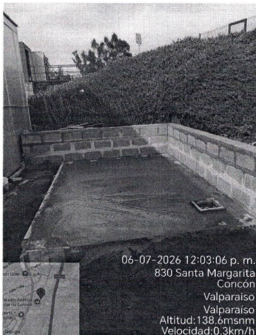
Imagen hormigonado Bodega pinturas
