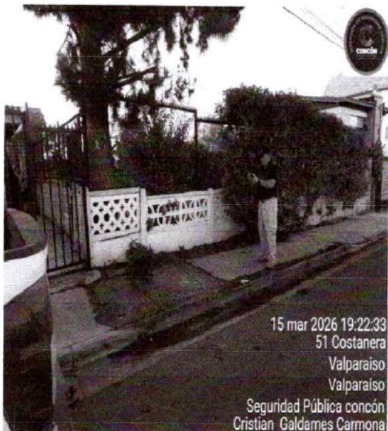
ROTURA DE MATRIZ DE AGUA POTABLE CALLE COSTANERO N° 51
