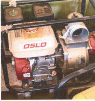
Apoyo e inspección para mantenimiento motobombas plan invierno
