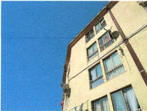
REPOSICION DE BAJADA DE AGUAS LLUVIA
